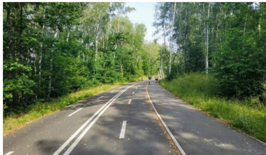
Rys. 9.4 Autostrada rowerowa Jaworzno, Polska
