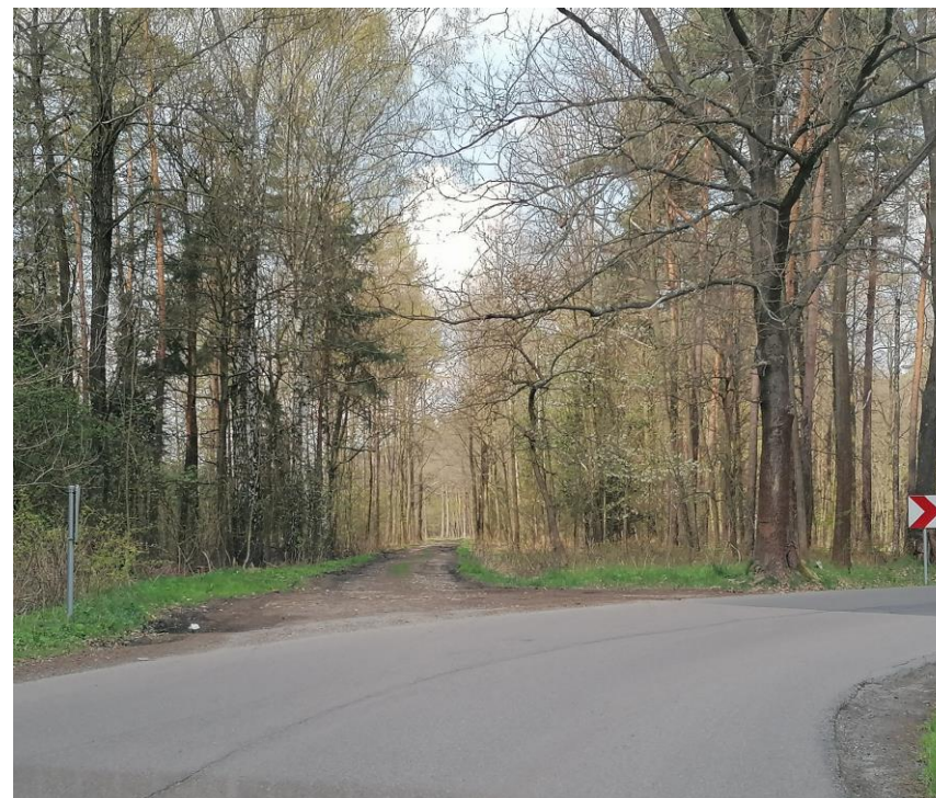
Rys. 5.1 Droga powiatowa o nawierzchni gruntowej – Wiry, ul. Macierzanki
