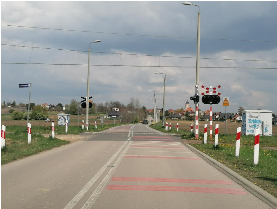
Rys. 4.6 Przejazd kolejowo-drogowy kategorii C – Wiry, ul. Tysiąclecia.
