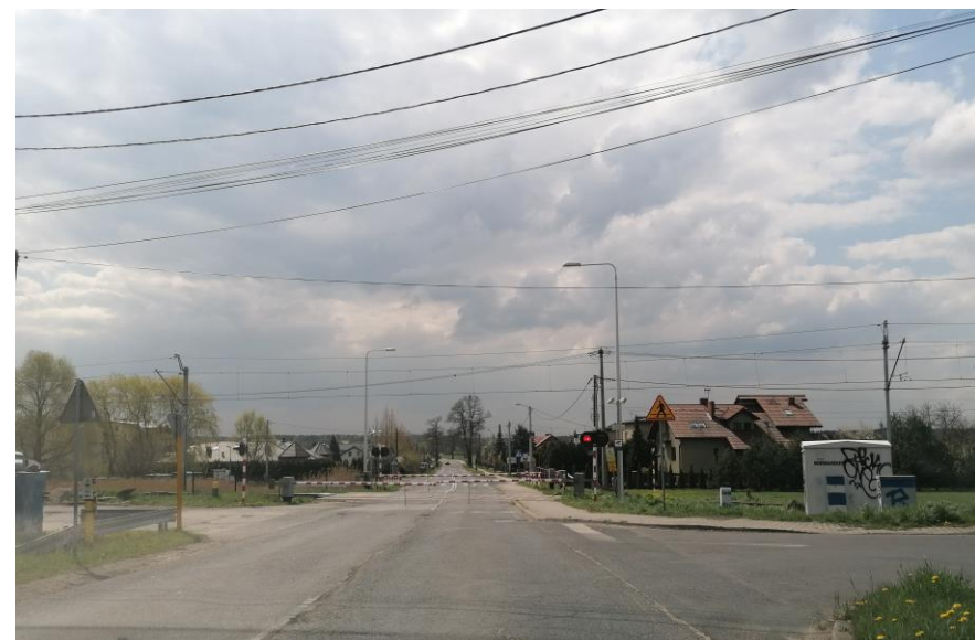
Rys. 4.5 Przejazd kolejowo-drogowy kategorii B – Wiry, ul. Pszczyńska
